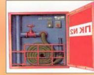
Для приведения в действие имеющихся в зданиях пожарных кранов откройте дверцу шкафчика, раскатайте в направлении очага пожара рукав, соединенный с краном и стволом. Откройте вентиль поворотом маховичка против хода часовой стрелки и направьте струю воды из ствола в очаг горения.
